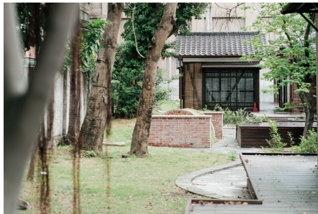
甫修復完的齊東街 53 巷 2、4、6、8、10 號， 成為臺文基的一部分。
