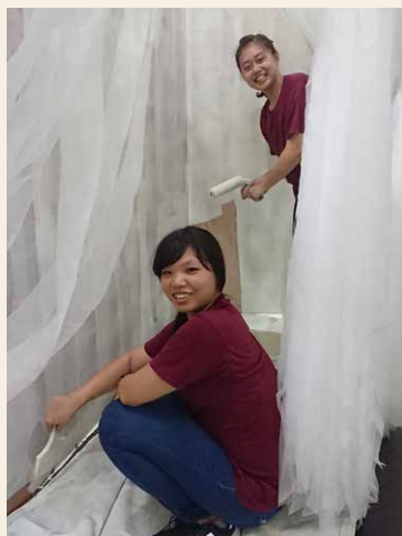
閉館後補強油漆工程。
