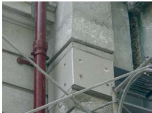
施工照片：天橋端部鋼樑包覆水泥板整修。
