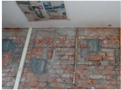
施工照片：磚牆加封不鏽鋼絲網補強。
