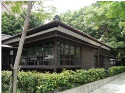
25號歷史建築的側向立面。
